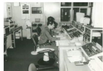
消防救急指令装置設置
