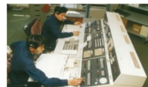
消防救急指令装置移設
