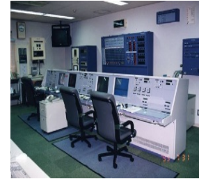
消防緊急通信指令施設更新
