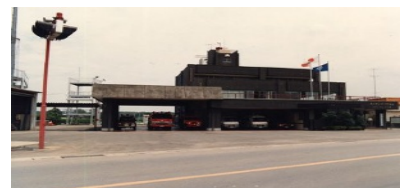
消防本部消防署庁舎竣工
