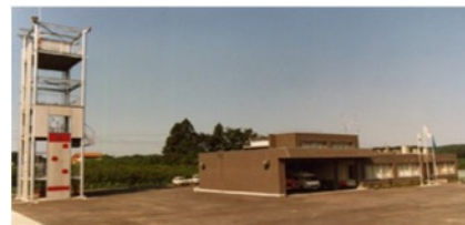
消防署鳩山分署訓練塔竣工
