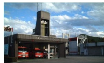
消防署越生分署竣工
