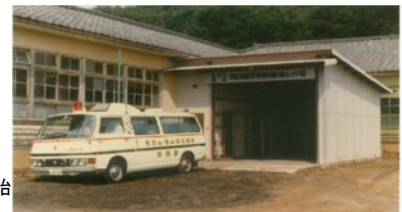
消防署仮鳩山分署
