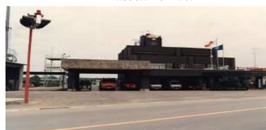
消防本部消防署庁舎竣工
