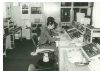
消防救急指令装置設置
