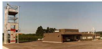
消防署鳩山分署訓練塔竣工
