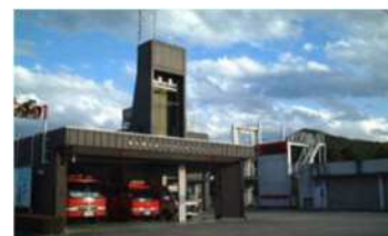
消防署越生分署竣工
